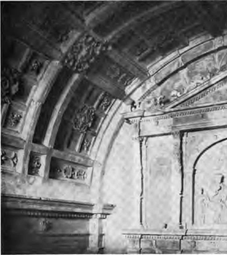
Fig. 160. — Voûte en berceau d'une église (actuellement atelier de carrosserie, à Coïmbra (Portugal). Voûte de style français avec arcs doubleaux et nervures transversales formant l'ossature des caissons sculptés.
